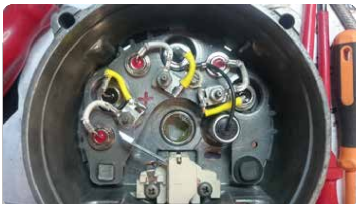
Binnenframe in buitenschaal gemonteerd. Alles aangesloten.
