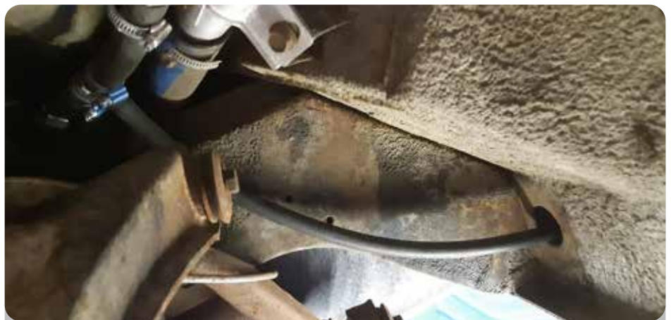
Retourleiding op ontluichtingsleiding
