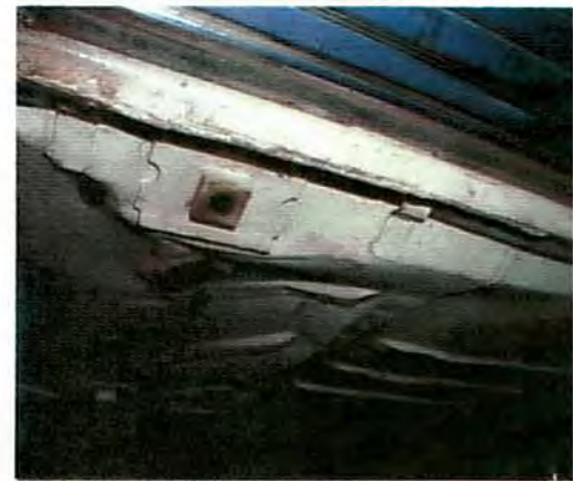
Foto: De deuk in de vloer als gevolg van een té hoge en korte drempel.
